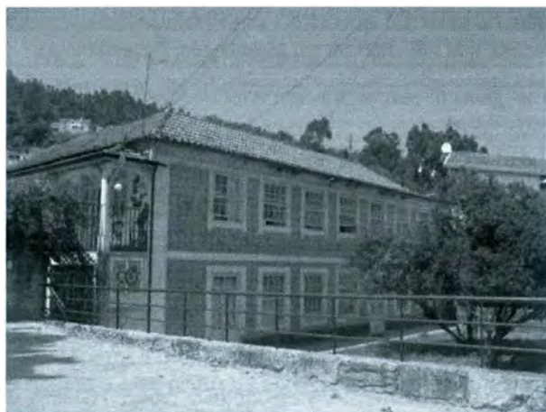
FIGURA 2. Casa do Comendador Pereira Inácio na freguesia de Baltar
