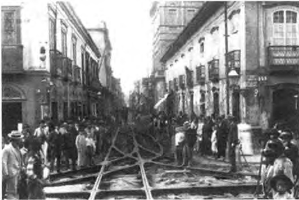
FIGURA 2. Cidade de São Paulo – Instalação de trilhos de bonde. Rua Direita, 1900
